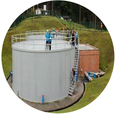
Fugas en tanques de almacenamiento
